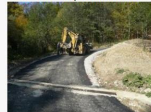
Dodatočné osadenie odrážky
